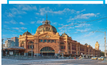
福林德街火車站
