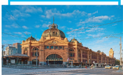
福林德街火車站
